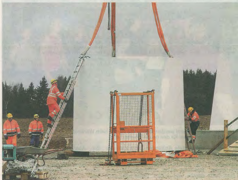
Die neuartigen Hybrid-Bauelemente für den Turmbau stammen aus dem Bögl-Hauptwerk in Sengenthal. Bis zu 70 Tonnen liftet der Drehkran in die Höhe. Foto: Pfrogner
