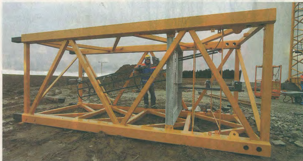
Diese Bauelemente aus Stahl lassen Zug um Zug den Turmdrehkran mit den Windkraftmasten in die Höhe wachsen. Bögl setzt die bekannte Technik nahe Bischberg erstmals beim Bau von Windrädern ein. Fotos: Edgar Pfrogner
