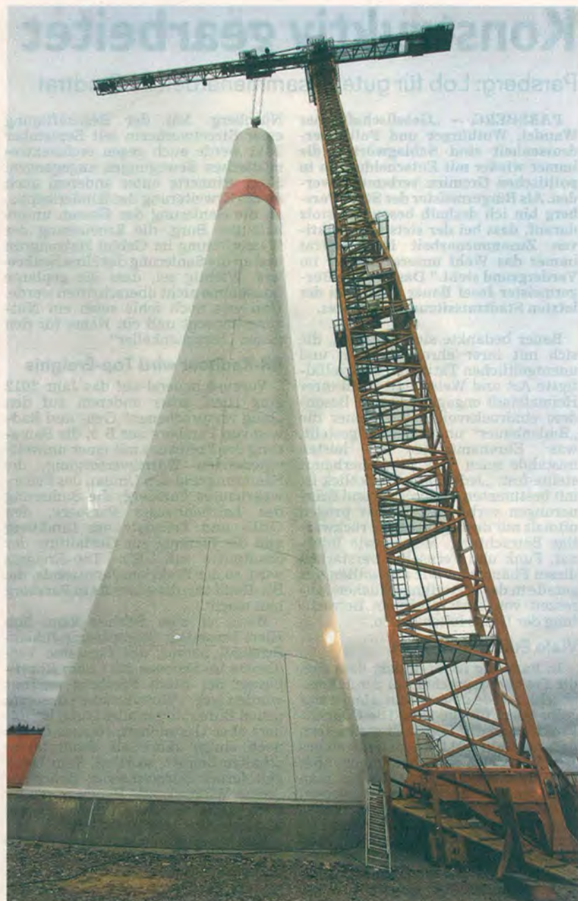
Der Grundriss des Turmdrehkrans am Fuß des Windradturmes hat gerade die Fläche von mehreren Esstischen. Weniger Grund bedeutet Einsparung. F.: Pfrogner
